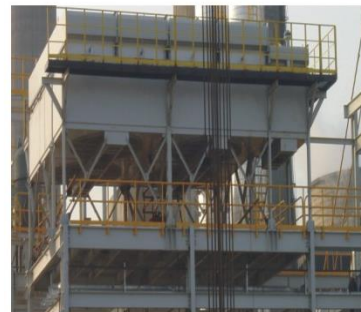
▲ 空冷器在甲醇（化工）生产项目的应用 CNOOC Hainan 600kT/Yr Methanol Air Coolers
